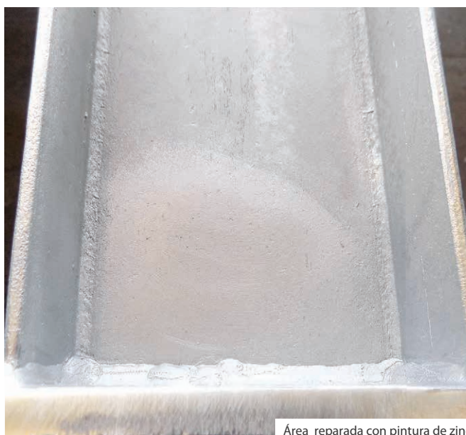
Área reparada con pintura de zinc
